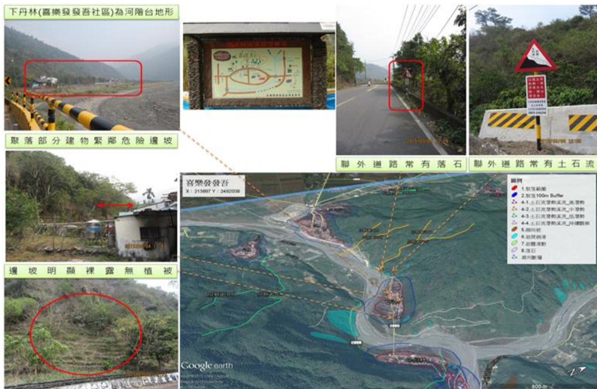
圖 2、喜樂發發吾社區地質災害調查（資料來源：國家災害防救科技中心）
