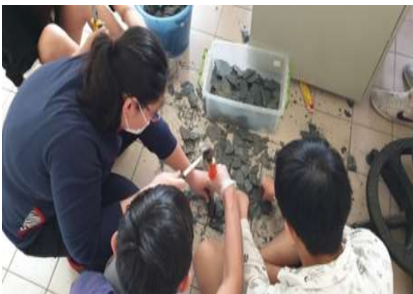
圖 25：石板的大小需要修，一塊一塊敲碎再組裝
