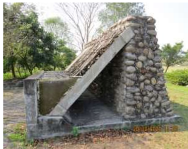
圖 18：泗林森林遊樂區內-梯形堰體模型(二峰圳)
